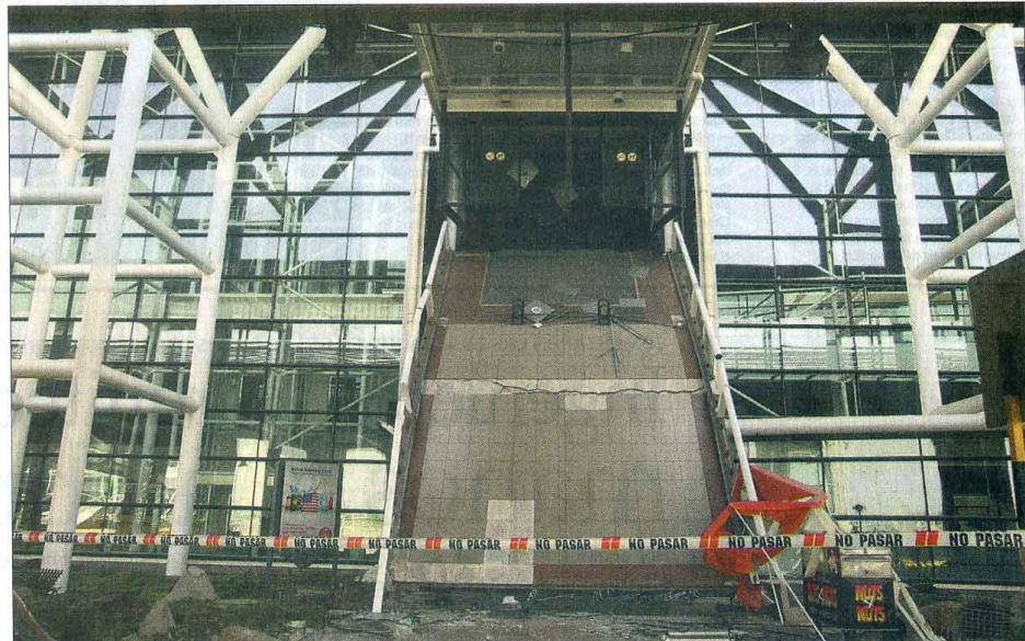
La caída de las pasarelas de ingreso al tercer piso del terminal estaba dentro de los cálculos, según el gerente de la concesionaria SCL. El objetivo: evitar que dañaran la estructura principal.
