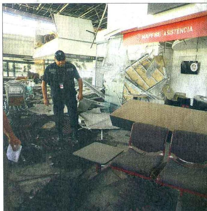
Los ductos instalados en los techos y los cielos falsos del terminal aéreo de Santiago sucumplieron con la fuerza del terremoto de la madrugada del sábado.
